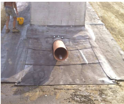
vista area a valle del pozzetto di carico
