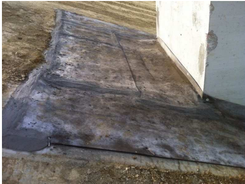
vista area a monte del pozzetto di carico
