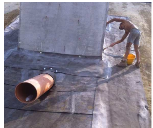
operazione di sigillatura con boiaccia di cemento
