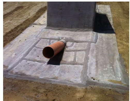
vista lavoro ultimato a valle
