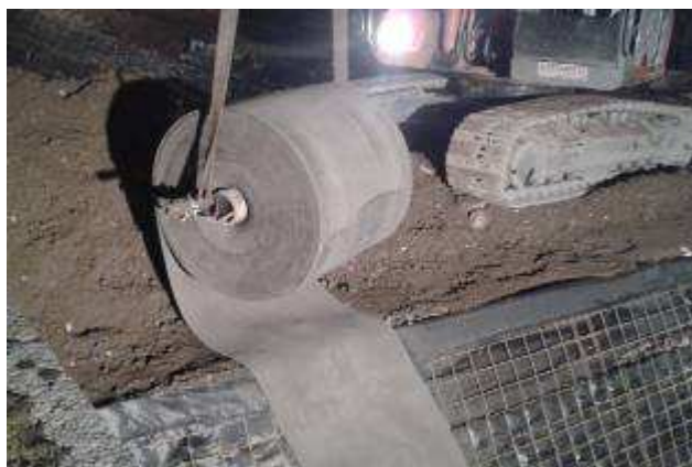
particolare movimentazione con escavatore
