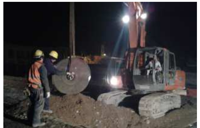
movimentazione della bobina di CC8
