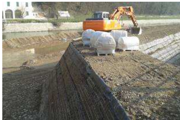
arrivo CC8 in cantiere
