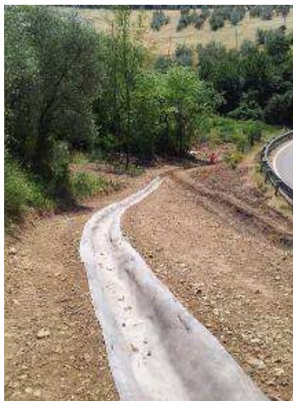
fase avanzamento cantiere vista monte
