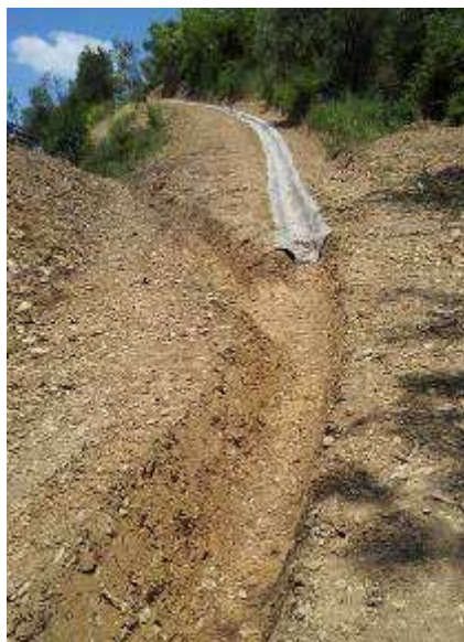
fase avanzamento cantiere vista valle
