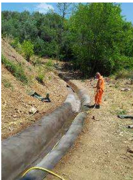
fase di idratazione
