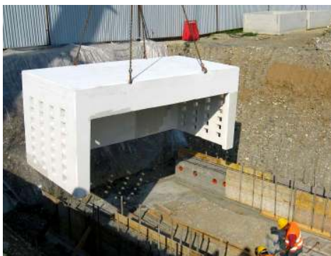
posa elemento di testata SIS
