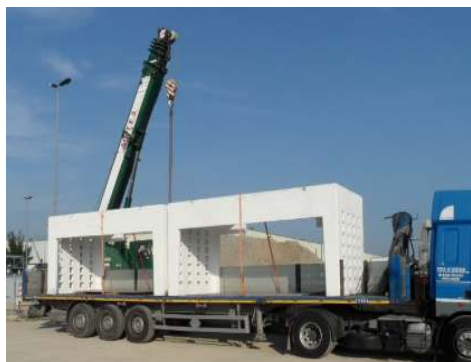
fasi di movimentazione degli elementi
