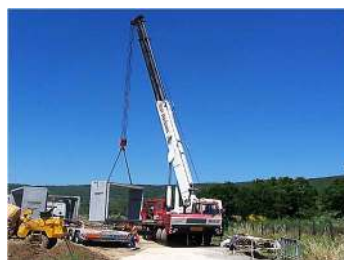
arrivo scatolari sul cantiere
