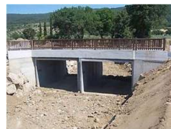
lavoro finito e ripristino viabilità
