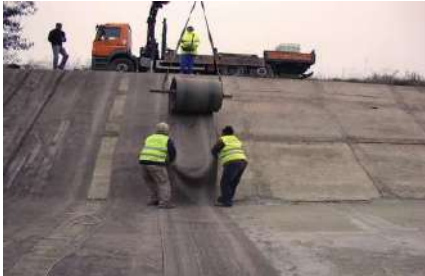
posa del geotessuto CC
