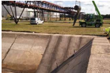
posa del geotessuto CC
