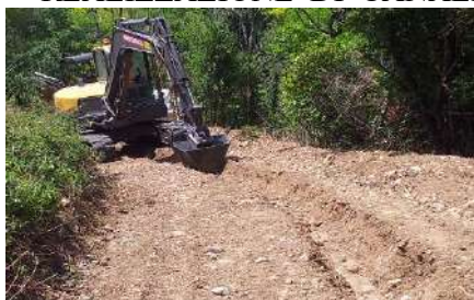
sagomatura del terreno
