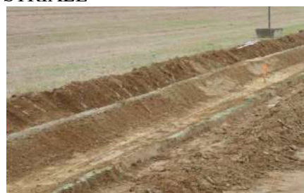
sagomatura area posa geotessuto CC
