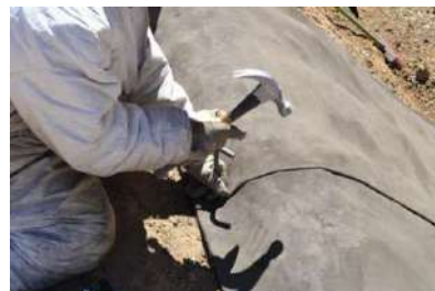
ancoraggio prima dell'idratazione
