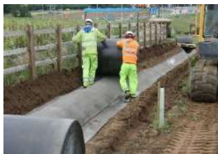
1: stendere il geotessuto CC sull'area dell'intervento
