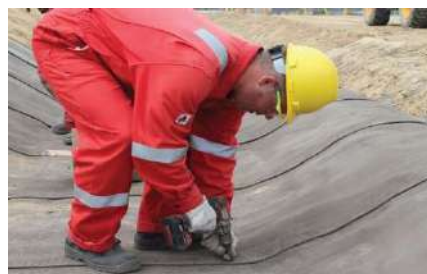
fissaggio geotessuto CC
