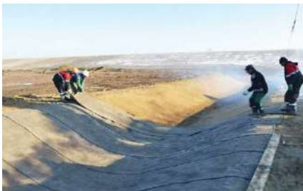
momento della posa del geotessuto
