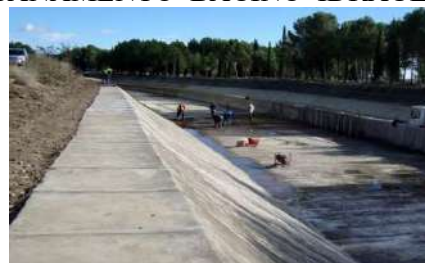
fasi di posa
