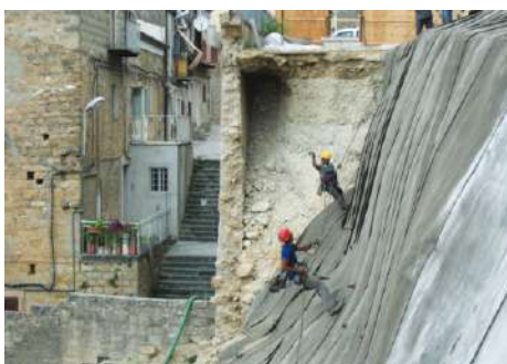
Intervento di messa in sicurezza
