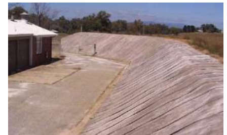
soluzione: utilizzo del geotessuto CC per mettere in sicurezza l'area ed impedire nuove frane
