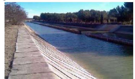
lavori terminati e bacino in esercizio
