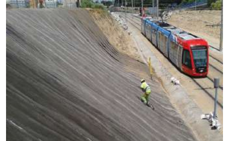
fasi di lavorazione
