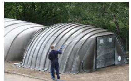
ancorata la struttura al suolo, inizia la fase di idratazione con acqua
