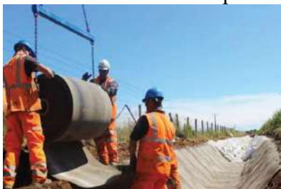
posa trasversale del geotessuto CC
