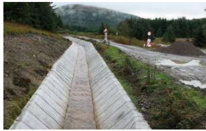
dopo l'intervento con geotessuto CC
