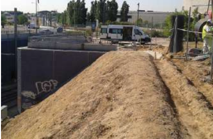
preparazione area dell'intervento
