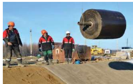
posa del geotessuto CC
