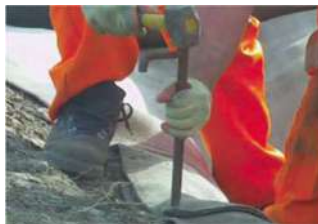
3: Ancorare il geotessuto CC al terreno
