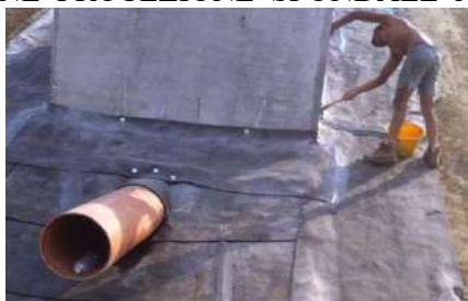
sigillatura con boiacca di cemento
