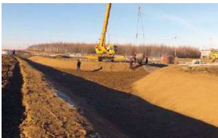
preparazione area dell'intervento
