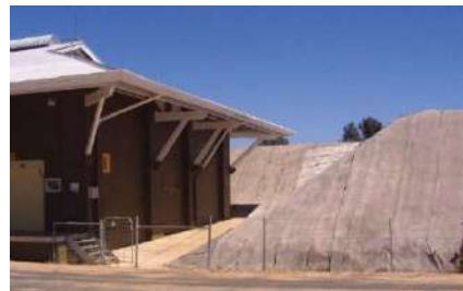
soluzione: utilizzo del geotessuto CC per mettere in sicurezza l'area ed impedire nuove frane
