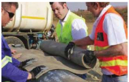
applicazione del geotessuto CC intorno al tubo
