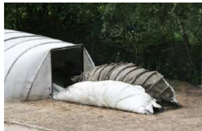
applicazione ventola elettrica per il gonfiaggio della struttura sino al suo auto-sostegno
