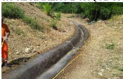
posa geotessuto CC – fase idratazione
