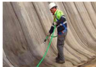
4: Idratare abbondantemente mediante getto d'acqua
