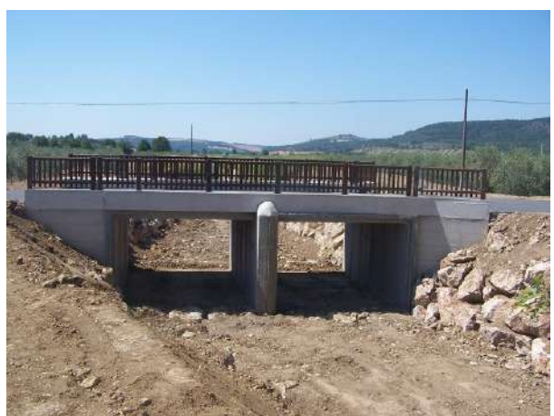
Lavoro finito vista di monte
