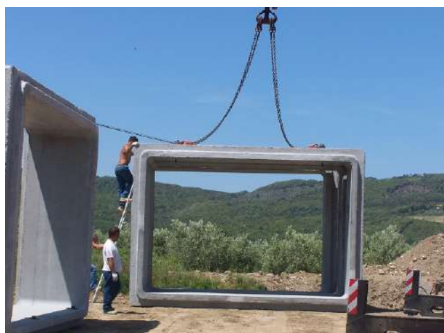
Movimentazione dei manufatti scatolari
