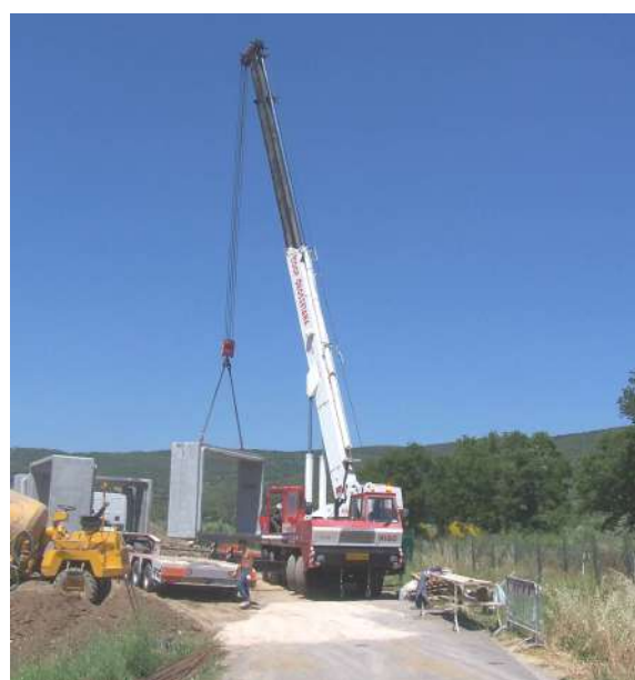
Arrivo dei manufatti scatolari in cantiere
