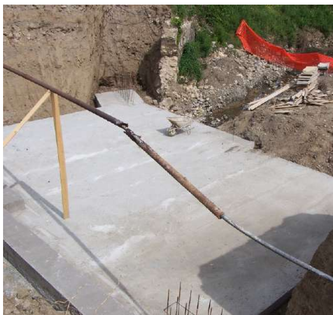
Soletta di appoggio dello scatolare
