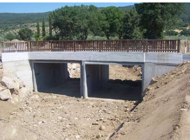
Lavoro finito vista di valle
