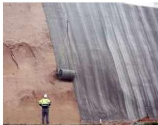
utilizzato per la protezione erosiva, nel contenimento della caduta massi e nella stabilizzazione delle scarpate
