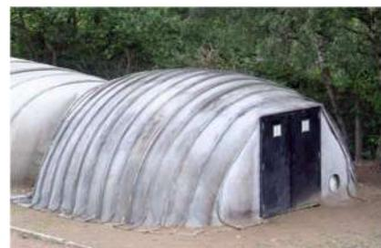
dopo due ore dall'idratazione la struttura è pronta per essere utilizzata
