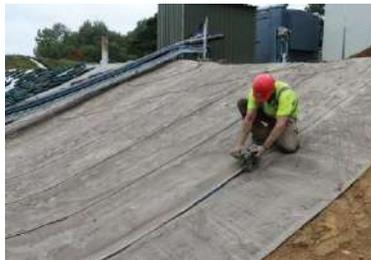
saldatura della geomembrana
