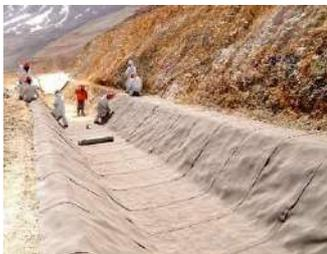
CC si srotola e si stende con rapidità per realizzare o risanare canali e canalette con geometria variabile
