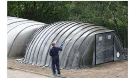
ancorata la struttura al suolo, inizia la fase di idratazione con acqua
